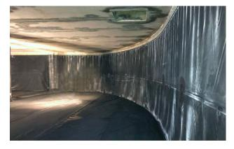
Le nostre **membrane Hidrostan EPDM** si rendono indipendenti dalle strutture esistenti e offrono una maggiore garanzia formando una pelle interna adatta a contenere l'acqua e liquidi assimilabili.
